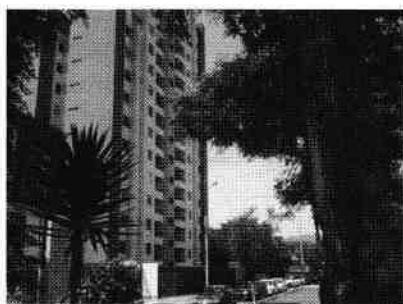
Edificios en construcción en Jesús María y Pueblo Libre
